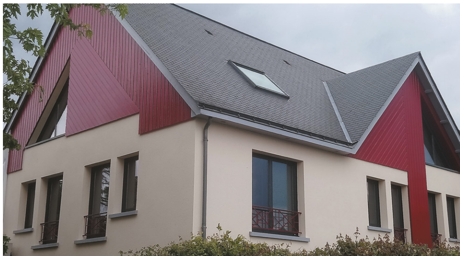
Le ravalement extérieur de la Mairie
